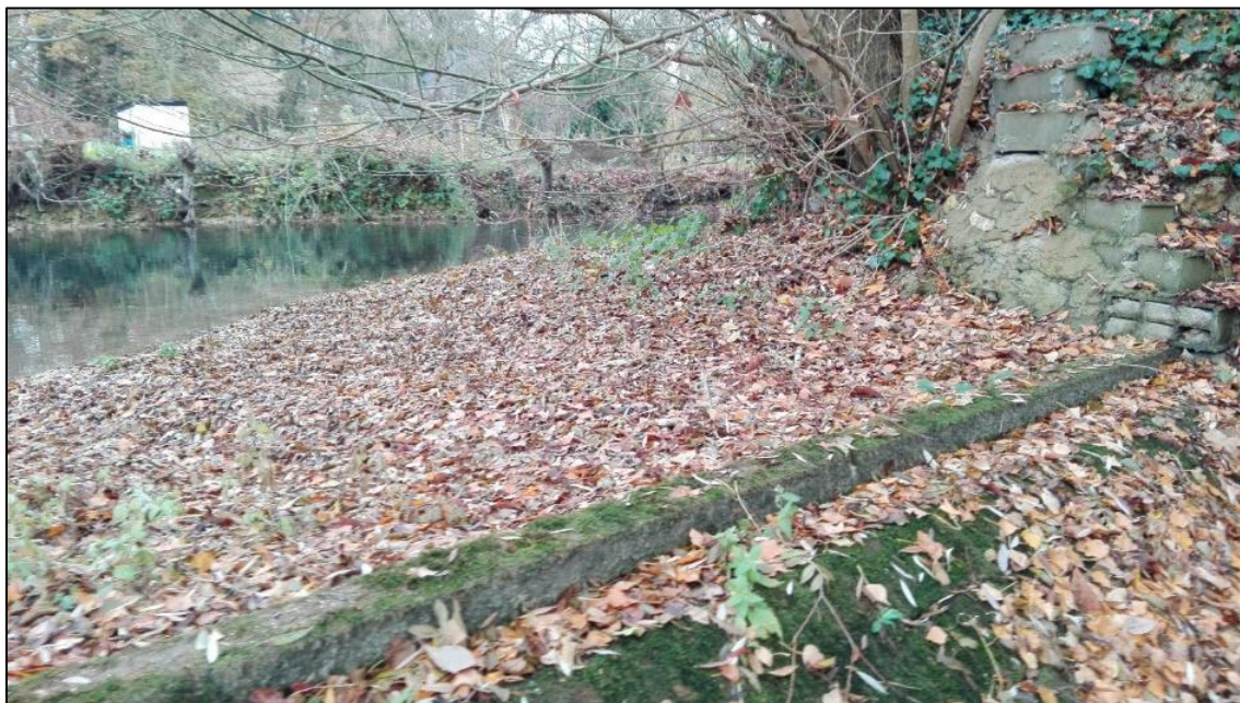
Rehausse béton sur l'ouvrage
