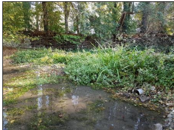
Dépôt en amont immédiat de l'ouvrage sur la Voiselle
