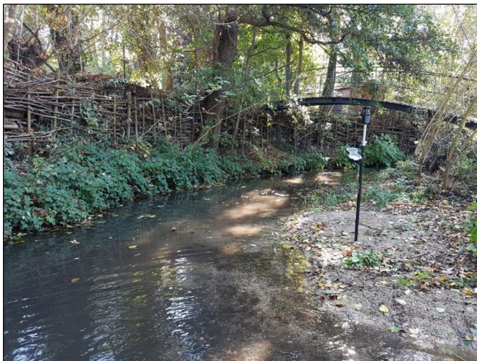
Dépôt de fines en aval de l'ouvrage sur le Faux-Pallouët dans la courbure et de grossiers en pied de berge rive droite
