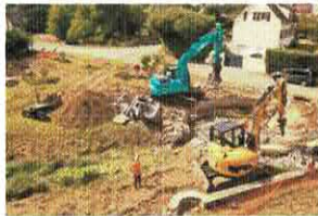
Démolition du dôme béton
