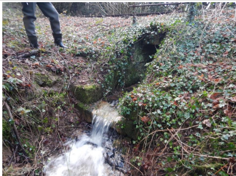
Exemple d'ouvrage à démanteler, 58 (Ingérop, 2020)
