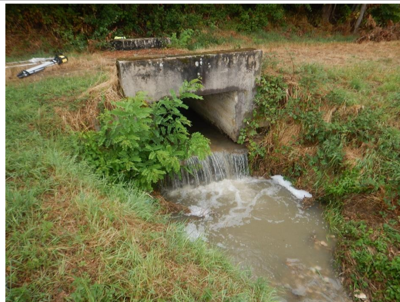
Exemple d'ouvrage à démanteler, 21 (Ingérop, 2020)
