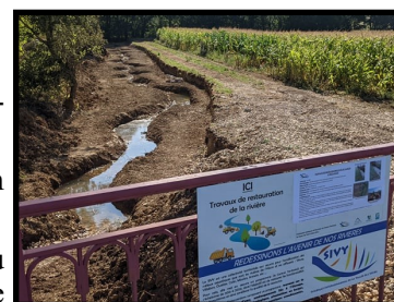
Travaux sur le Langis (Soulangis)
