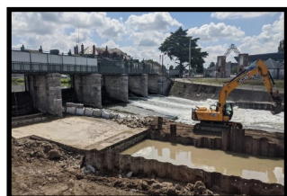
Démarrage des travaux à Vierzon
