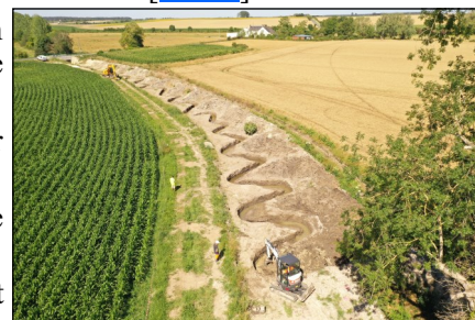
Chantier de l'Yèvre à Baugy
