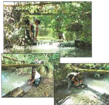
Arasement d'un seuil
