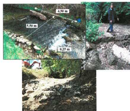
Dérasement d'un seuil
