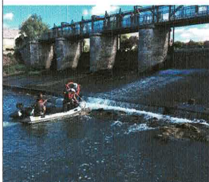
Barrage de l'Abattoire (Vierzon)
