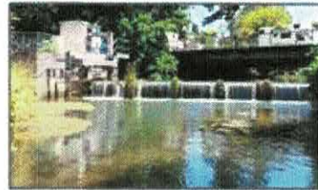
Clapet Saint-Ambroix à Bourges
