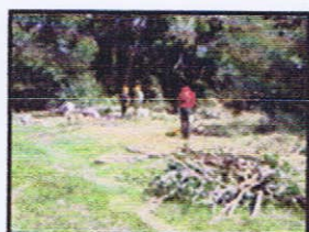
Chantier embâcle à Bourges (Moulon) (ASER)
