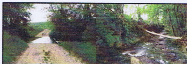
Réfection passage à gué sur le Colin (Aubinges) – travaux prévus en juillet (Millet)
