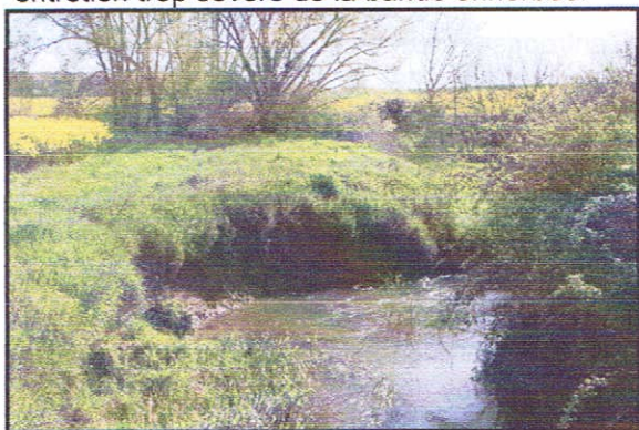
Photo n°3 : érosion de berge
