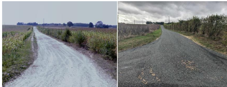
Figure 10 : imperméabilisation d'un chemin en 2023 aux abords du Cher (SIVY)
