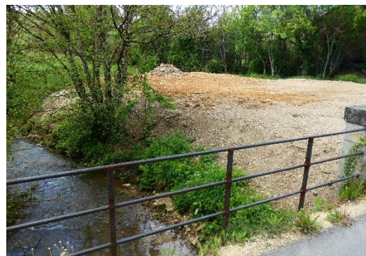
Figure 13 : Remblai en lit majeur du Moulon (SIVY)
